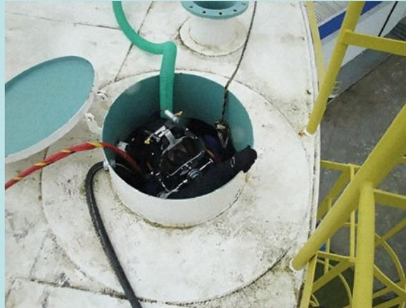
Mergulhadores especializados entram nos reservatórios de água com aparelhos que fazem a limpeza de pisos e paredes por sucção.
