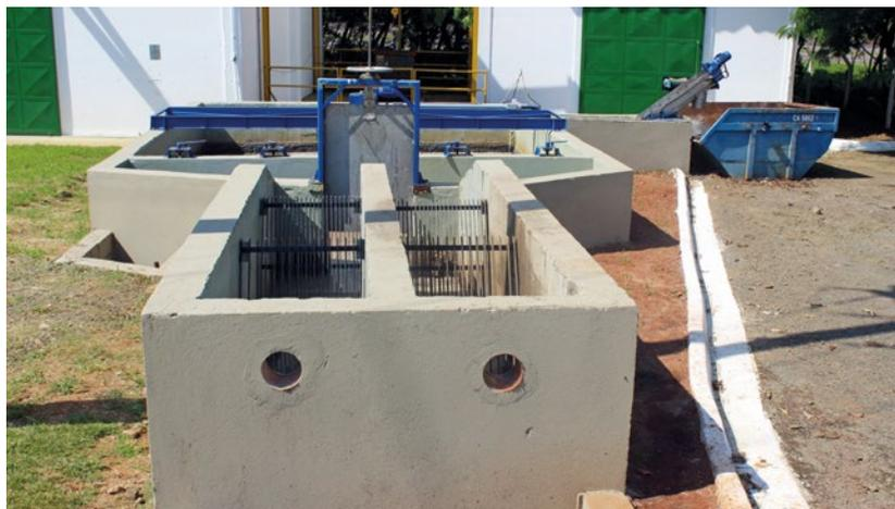
A conclusão da implantação do novo sistema de tratamento preliminar proporciona remoção de areia e detritos de forma mais eficiente.
